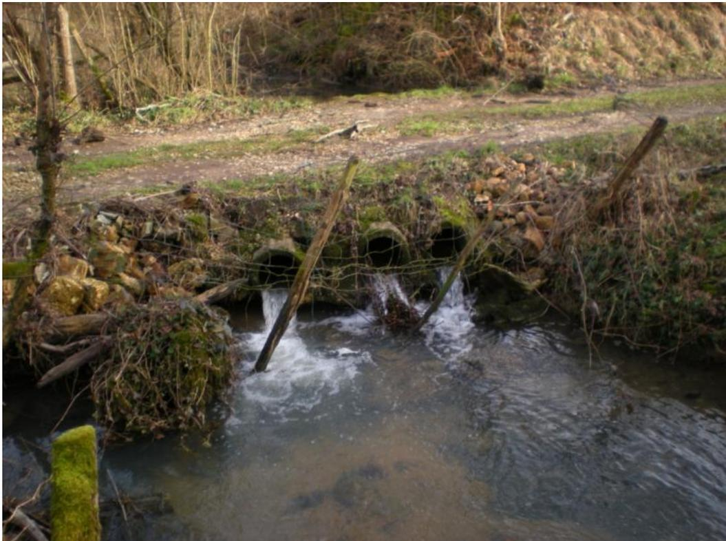
Fig.23 : Exemple passage busé « mal callé » totalement infranchissable
