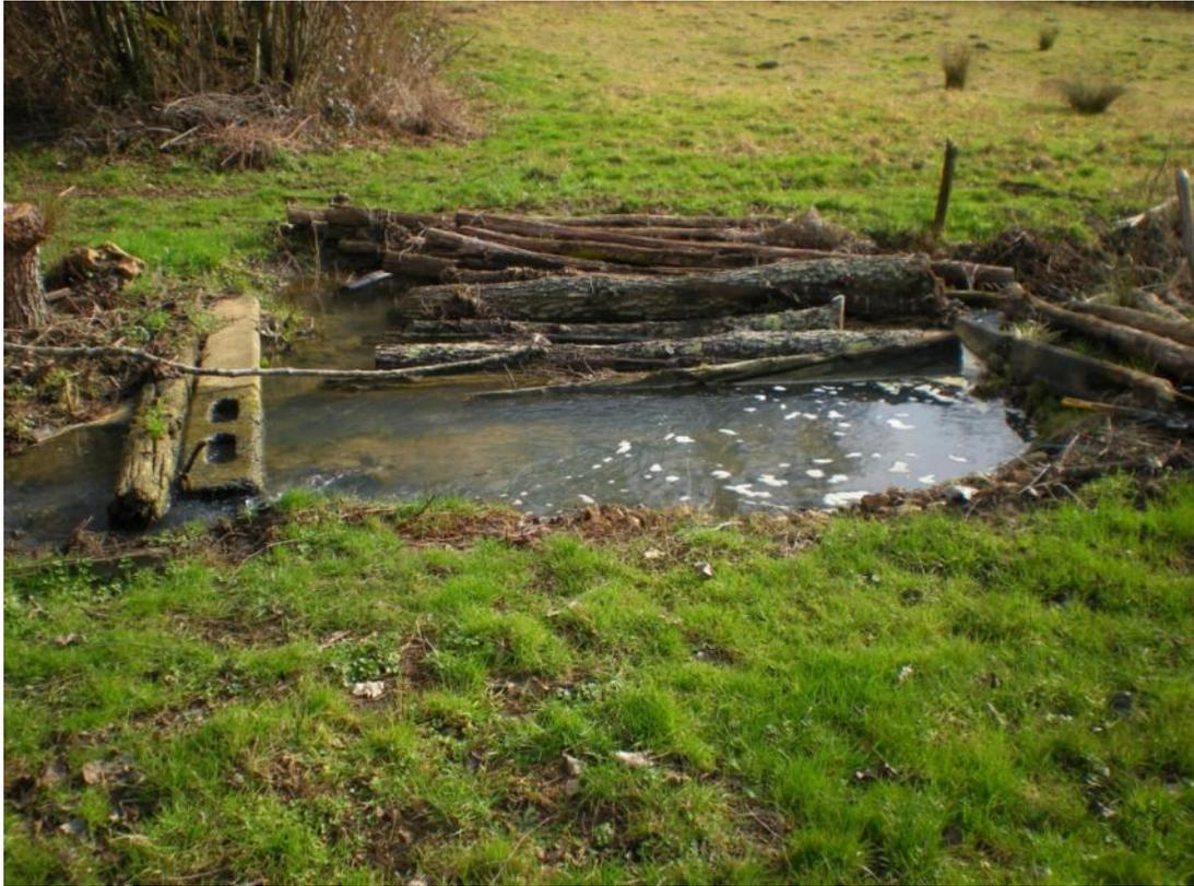
Fig.22 : Exemple de passage à qué « artisanal » pénalisant le fonctionnement de la rivière
