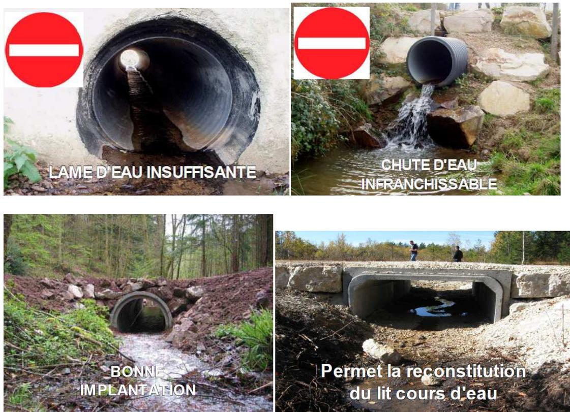
*Fig.30 : Exemple de situation et de moyens de correction du mauvais calage d'ouvrage de franchissement*
