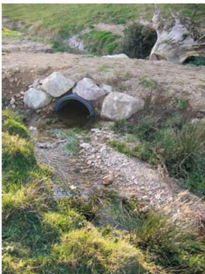
*Fig.29 : Exemple de moyen de franchissement garantissant la transparence de l'ouvrage*
