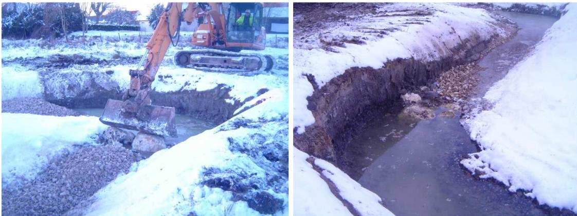
*Fig.27 : Photos de réalisation d'un seuil d'enclaque à l'aval d'un radier*
