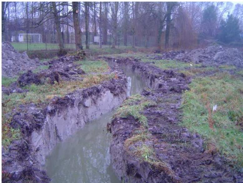
*Fig.21 : Photos du commencement des travaux - décaissement du volume situé au-dessus du lit mineur*
