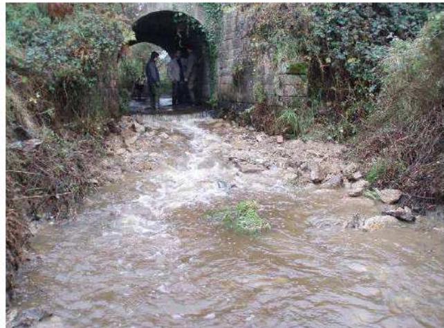
**Fig.31 : Exemple de mise en place de rampe en recharge granulo-caillouteuse**
