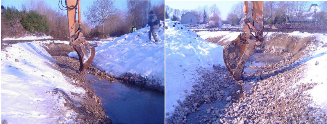
*Fig.25 : Photos de la répartition des matériaux plus fine à l'aide d'un godet*
