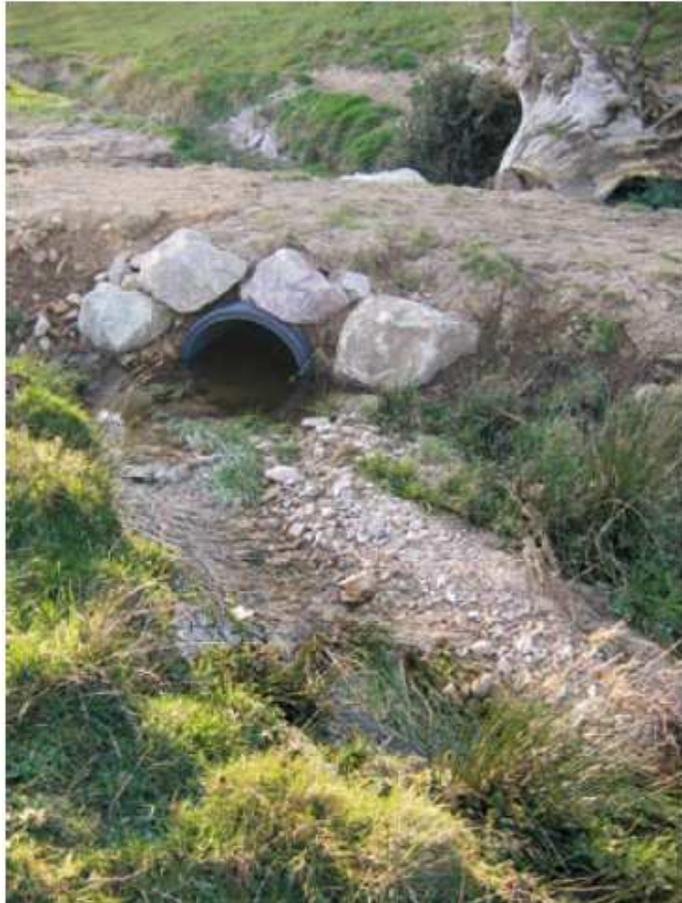
Fig.27 : Exemple de moyen de franchissement garantissant la transparence de l'ouvrage
