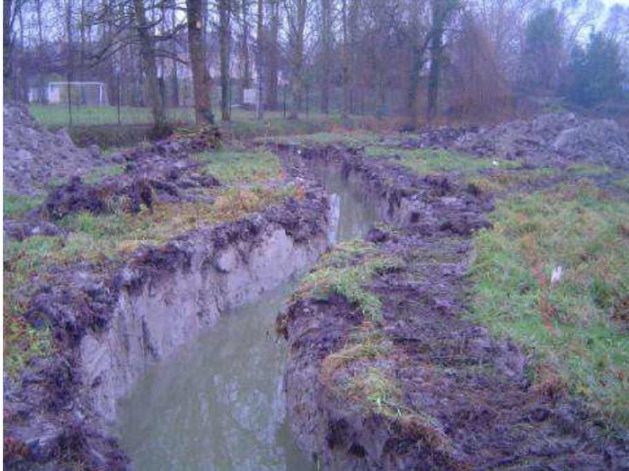
*Figure 24 : Photos du commencement des travaux - décaissement du volume situé au-dessus du lit mineur*
