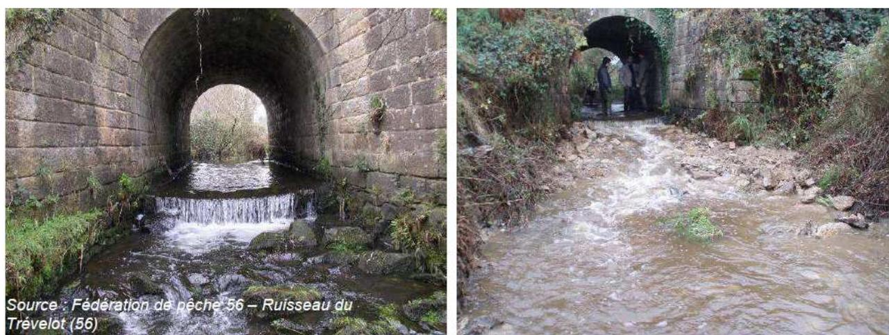
*Fig.29 : Exemple de mise en place de rampe en recharge granulo-caillouteuse*
