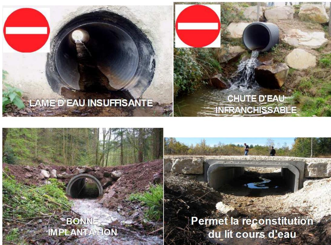
*Fig.28 : Exemple de situation et de moyens de correction du mauvais calage d'ouvrage de franchissement*
