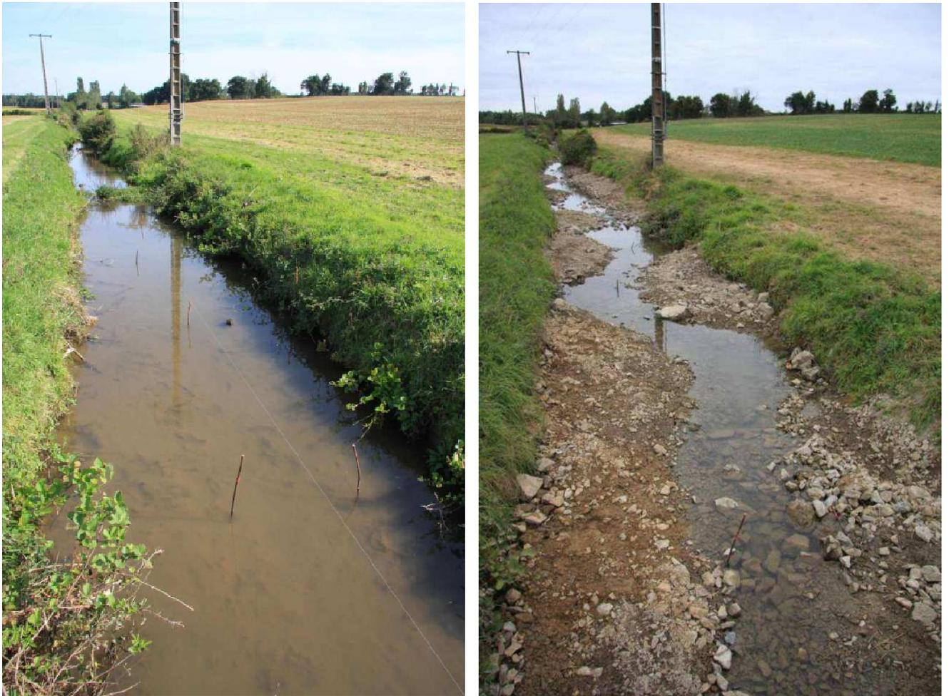
*Fig.18 : Exemple de travaux de recharge granulométrique sur un cours d'eau rectifié et recalibré sans capacité d'accueil pour les espèces aquatiques (source ONEMA)*
