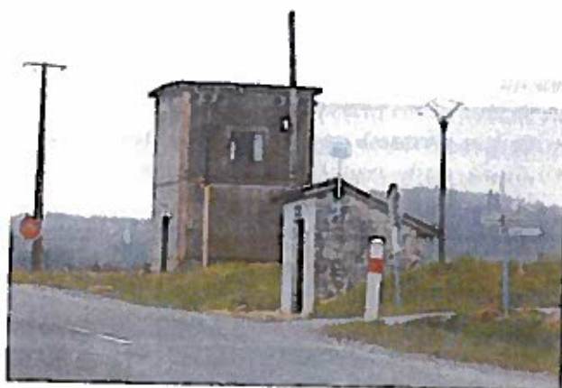
Les 2 constructions présentes actuellement sur la zone
