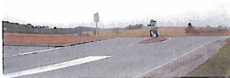
L'accès à la RD 939 depuis la RD 106.
