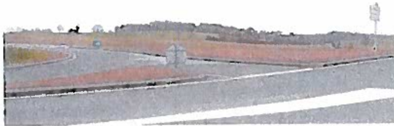
Ce carrefour permet une desserte sécurisée de la zone d'activités.
